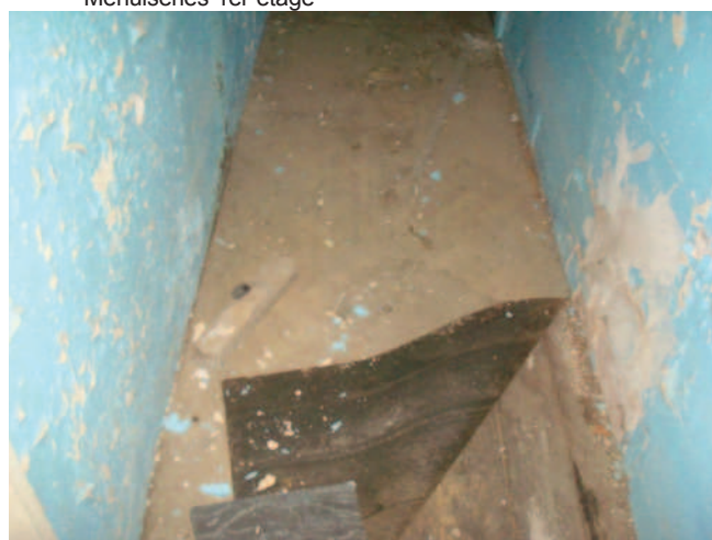
Composant : Les plastique avec sous couche Imitation plancher bois flottant Placard en sous escalier (combles)
