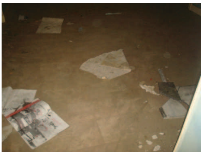
Composant : Les plastique avec sous couche Imitation carrelage Chambres 1 et 2
