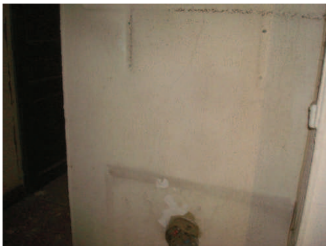
Composant : Enduits projetés Enduit plâtréux Totalité 1er étage
