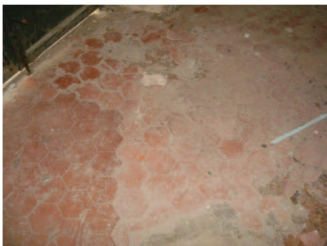
Composant : Colles des carrelages Colle sous tomlette Escalier
