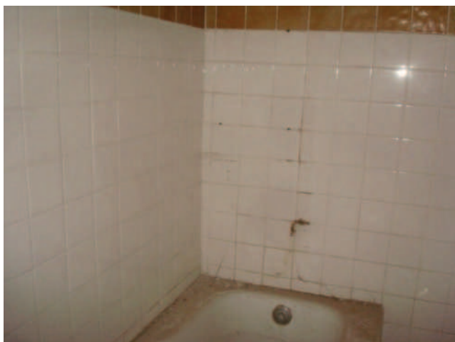
Composant : Colles des carrelages Colle carrelage mur (10x10 blanc) Salle de bains
